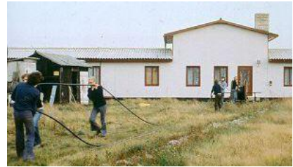
Stationsbau. Foto: bereitgestellt H. Baudler
