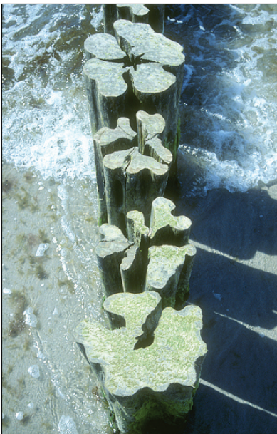
Abb. 8: Einsatz von Tropenholz im Buhnenbau: Querschnitt durch Acariquara-Pfähle; Use of tropical wood for groyne construction: Cross-section of Acariquara piles. Foto:Archiv IWR
