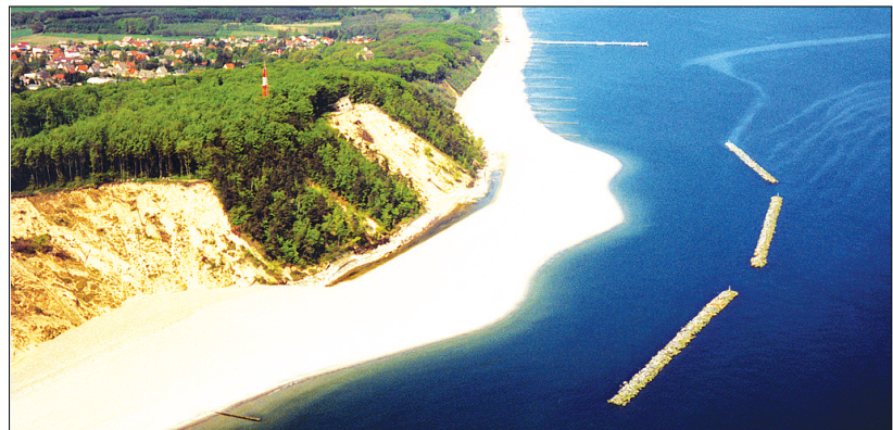
Abb. 3: Küstensicherungsmaßnahme am Streckelsberg/Isle of Usedom; Protection measures at Streckelsberg/Isle of Usedom.
