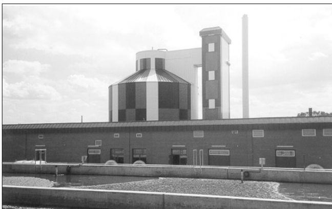
Abb. 4: Kläranlage in Wismar (Bild: Dr. Barjenbruch); Sewage treatment plant in the town Wismar (pic.: Dr. Barjenbruch).
