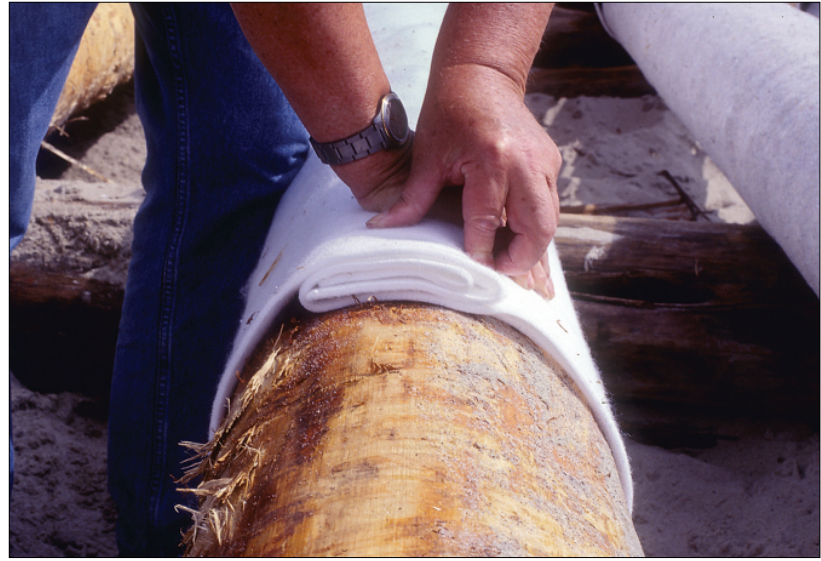
Abb. 9: Schutz von Buhnenpfählen durch geotextile Manschetten / Testfeld Kühlungsborn; Protection of groyne piles using a geotextile cuff / test field at Kühlungsborn.
