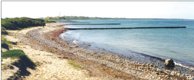
Abb. 4: Typisches Buhnenfeld aus Holz-Pfahlreihen (Beispiel: Dranske/Rügen); Typical example of a groyne field of wooden piles: Dranske, Isle of Rügen. Foto: Archiv IWR
