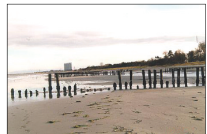
Abb. 6: Zerstörung von Buhnenpfählen durch Bohrmuschelbefall ( Teredo navalis ) / Warnemünde; Destruction of groyne piles by Teredo navalis / Warnemünde.
