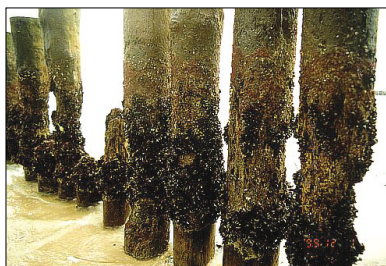
Abb. 6: Zerstörung von Buhnenpfählen durch Bohrmuschelbefall ( Teredo navalis ) / Warnemünde; Destruction of groyne piles by Teredo navalis / Warnemünde.
