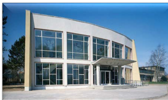
Hörsaalgebäude Albert-Einstein-Straße 2 Fakultät Maschinenbau und Schiffstechnik
