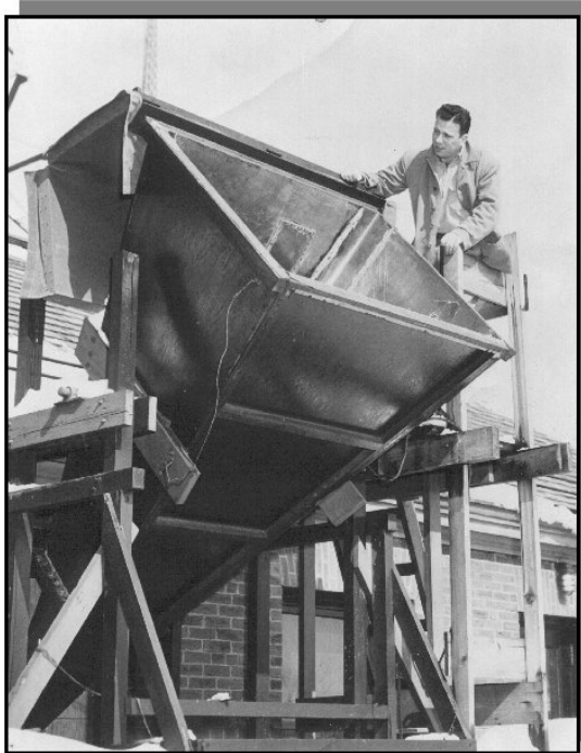
Radioantenne, die von Ewen und Purcell verwendet wurde, um die 21cm Emissionslinie des spin-flip Übergangs in atomaren Wasserstoff zu beobachten
