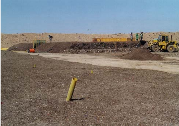
Abb. 3: Aufbau der Rottemieten nach dem Kaminzugverfahren
