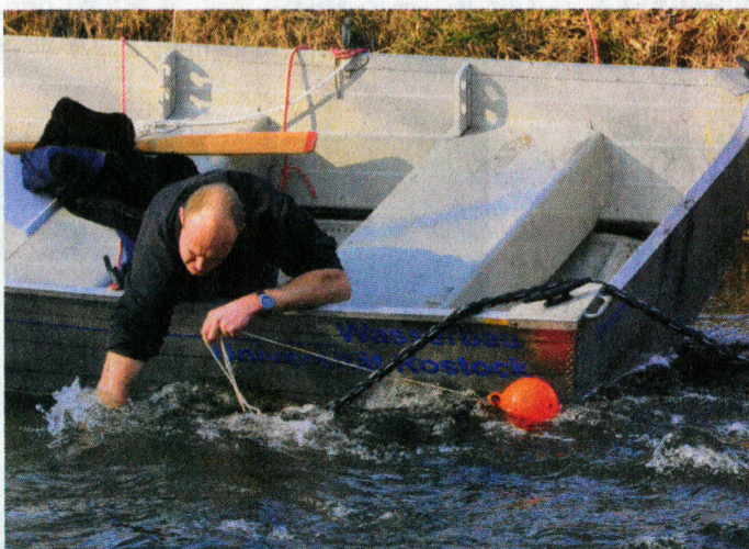
Frieren für die Wissenschaft: Dr. Frank Weichbrodt befestigt eine Boje am Beton-Anker im Wasser, der das Kraftwerk hält.
