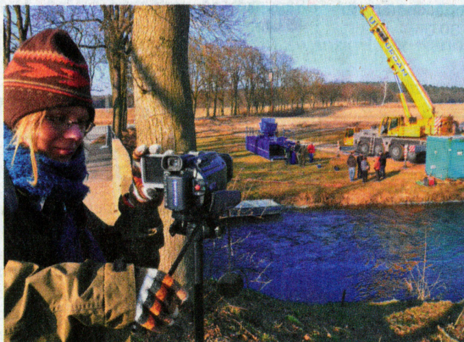
Steffi Dümke hält mit einer Videokamera fest, wie das Wasserkraftwerk in die Warnow gesetzt wird.
